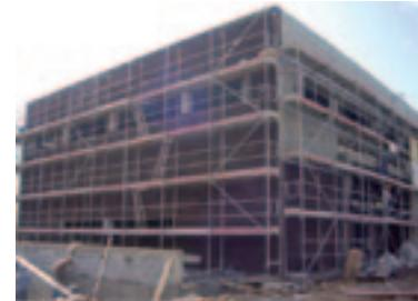
**Foto 1 – Mit Kork vorbereitete Fassade für die Platzierung des WDVS-Belags.**
